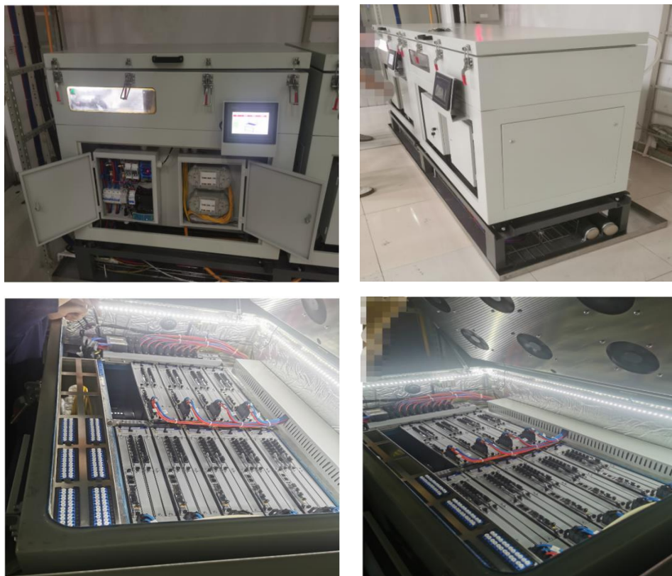
图 6 中国电信 5G BBU 机柜液冷试点
