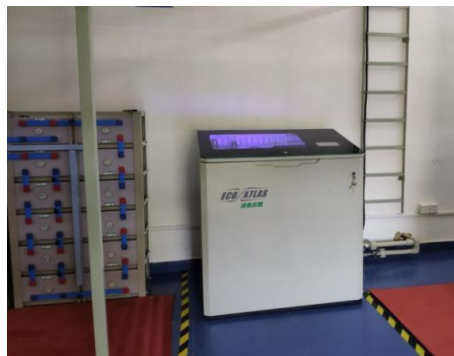
图3 中国移动 5G 基站单相浸没式液冷试点
