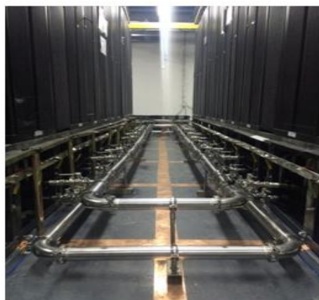
图1 中国移动南方基地气液双通道冷板液冷研究和实践
